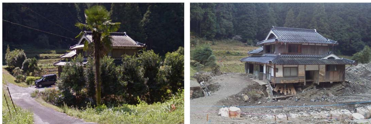
全壊した家屋の様子（左：被災前、右：被災後） 解説：写真の家屋手前の小川が濁流となり家屋の土台を一部削り取り、土砂は家屋の1階に侵入した。 ※左：GoogleStreet より
