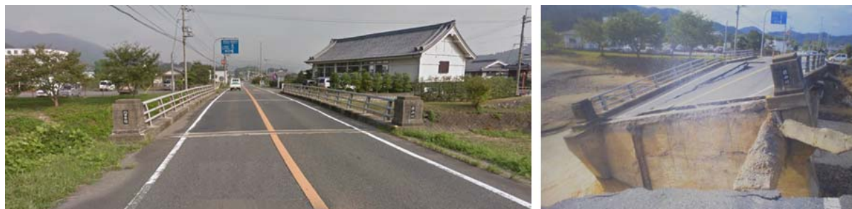
橋梁崩落の様子（左：崩落前、右：崩落後）※左：GoogleStreet、右：丹波市ご提供資料より
