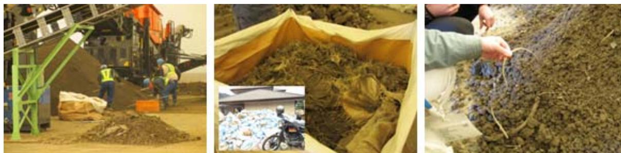
写真：二次仮置場土砂選別の様子（左）選別した土砂にさらに手作業を加えている様子（中）ボロボロになった土嚢袋（右）土砂中に混入している土嚢袋の一部
