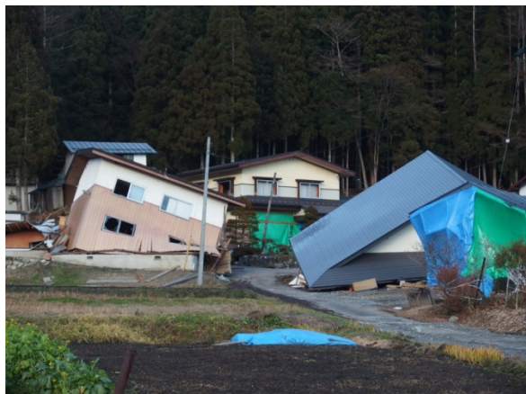
写真 家屋の被災状況（長野県提供）
