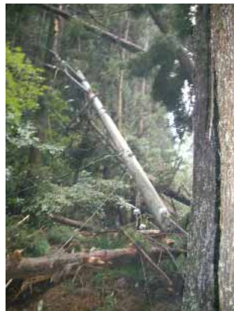
電柱の被害も2か所で発生 （東京電力提供）
