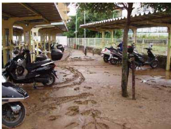
自転車駐車場の被害
