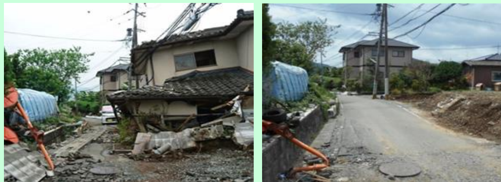
▲倒壊した家屋の解体・撤去の様子 (左)撤去前(右)撤去後
