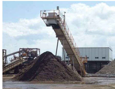
木くず破碎選別施設（宮城県南三陸町）
