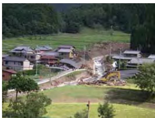
河川土砂撤去 （所谷川（津市））
