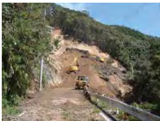
崩落土砂の撤去（県道飛鳥日浦線（熊野市））
