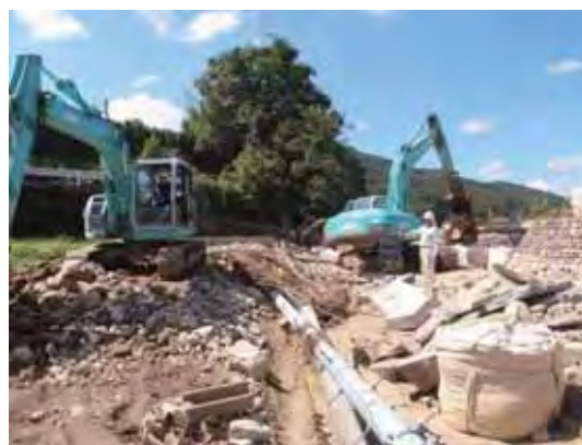
築堤護岸の応急対策（尾呂志川（御浜町））
