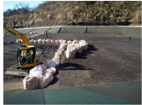
図4-6 大島一般廃棄物管理型最終処分場センター
