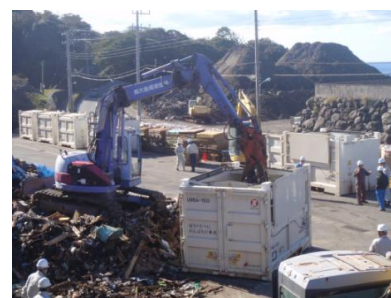
図 4 - 15 建設混合廃棄物
