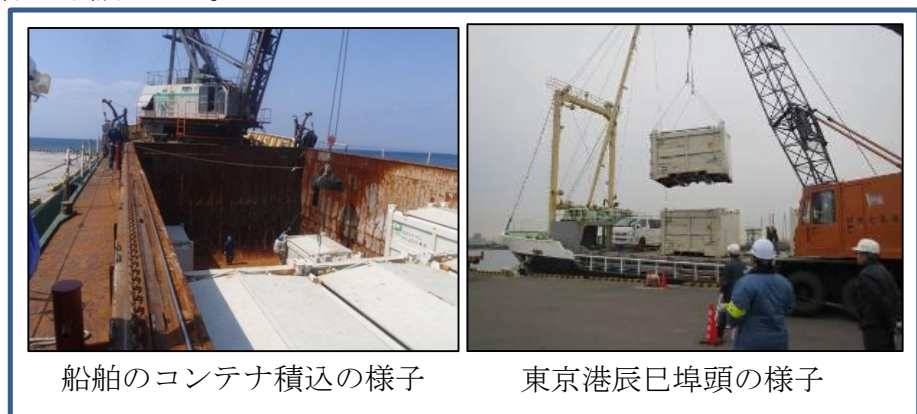
図6-14 ラフテレーンクレーンによる荷役
