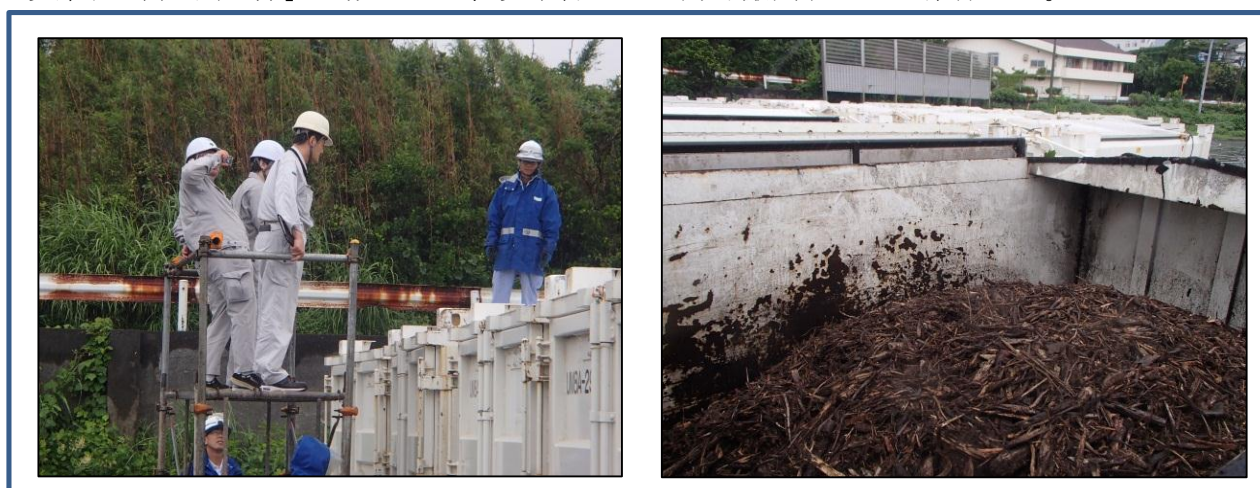
図6-15 廃木材（繊維状のものの破砕物）の搬出確認
