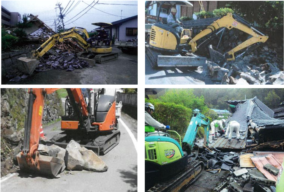
写真 2-4-1 道路上のがれき等撤去の様子
