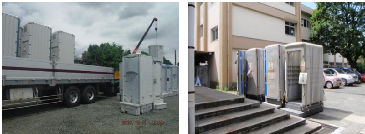
写真 2-5-1 仮設トイレ設置状況
