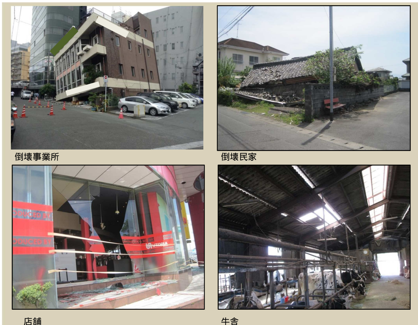
図 2-2 平成 28 年熊本地震による被害の状況（発災直後に撮影したもの）
