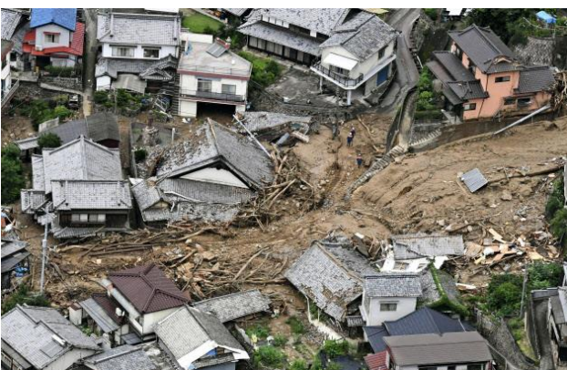
土砂に巻き込まれた民家（7日、広島県呉市阿賀町）
