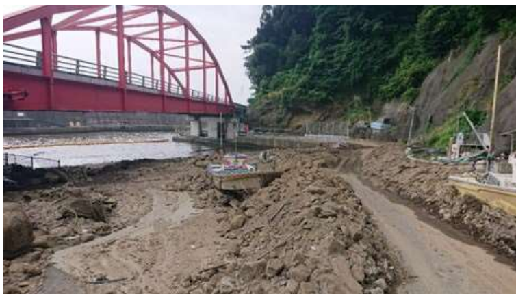
伊豆山港付近の被害の様子（令和 3 年 7 月 26 日）写真撮影：環境省
