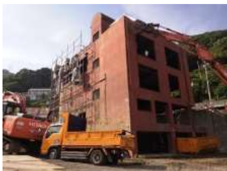
内装及び外配管等撤去
