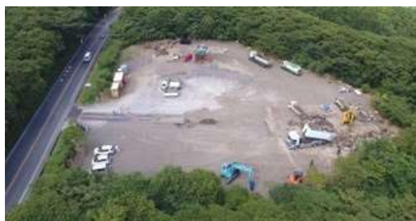
開設時の笹尻仮置場
