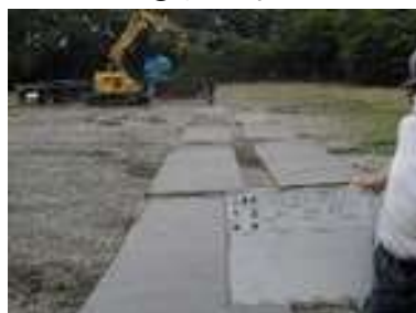
③敷鉄板搬入・布設
