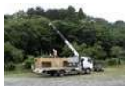
④ユニットハウス設置 (仮設トイレ、倉庫)
