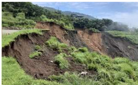
源頭部の被害状況
