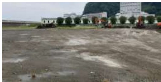
がれき置場用に用地拡張 （令和3年7月13日）写真撮影：熱海市
