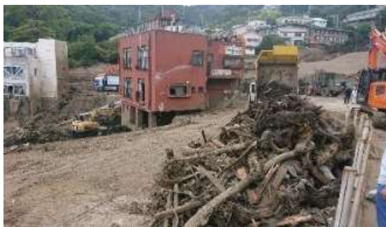
住宅地の被害状況
