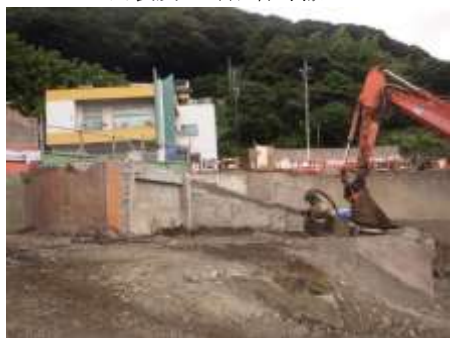
道路や河川の安全に必要な基礎を残して 解体工事を実施
