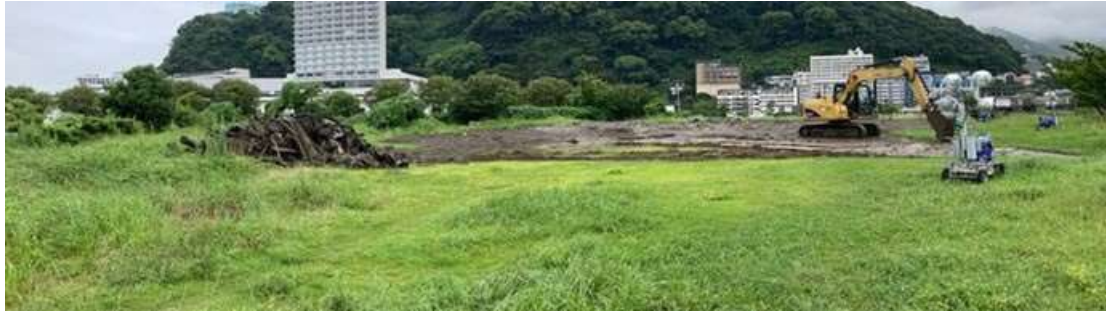
人命救助に伴い発生したがれき混じり土砂の搬入（令和3年7月4日）写真撮影：熱海市
