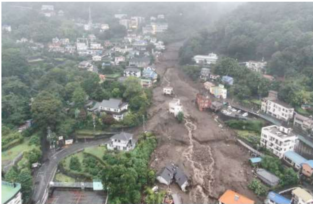
熱海市伊豆山地区土石流災害の被災地区 出典：国土交通省令和 3 年 7 月 1 日からの大雨による土砂災害発生状況 (令和 3 年 7 月 5 日 10:30 現在速報版)
