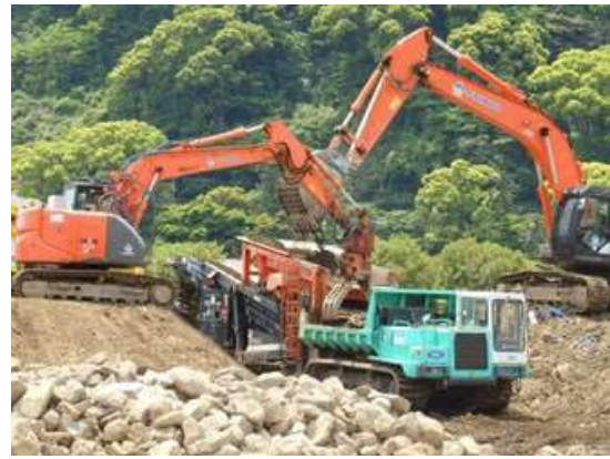
土砂篩い選別機による作業
