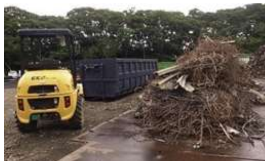
公費解体廃棄物からの金属くず(主に鉄筋)
