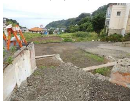
解体撤去跡地
