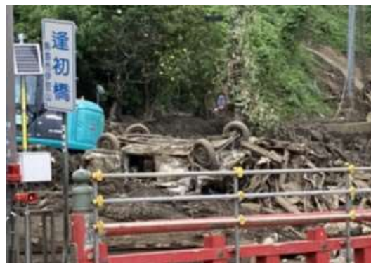
国道135号逢初橋 (令和3年7月11日)
