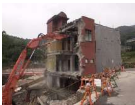
RC 家屋兼店舗解体
