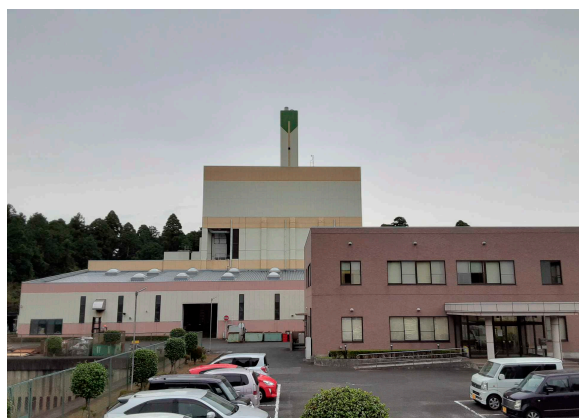
山武郡市環境衛生組合ごみ処理施設
