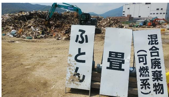
写真 4-5 仮置き場内の区分表示例（呉市）
