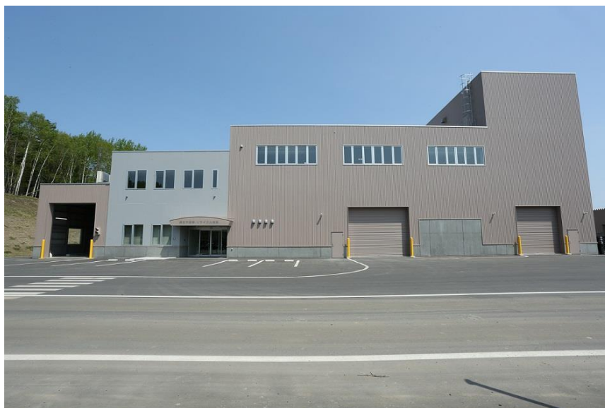
破砕・リサイクル施設
