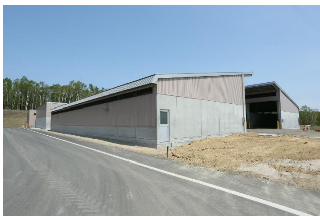
生ごみたい肥化施設
