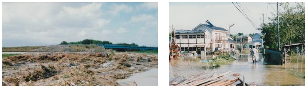
図 1-1 平成2年台風第19号災害による本市の被災状況
