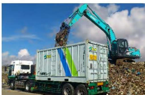
仮置場での海上コンテナへの積込
