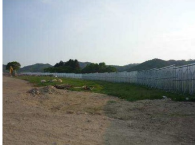
周辺へのフェンスの設置
