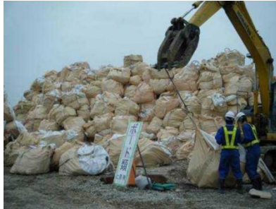
フレコンバッグへの封入（石膏ボード）
