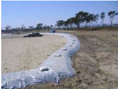
簡易遮水シートの敷設
