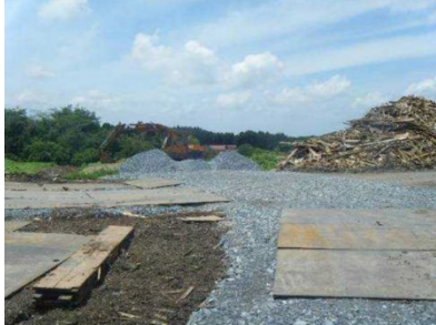
砂利と鋼板の搬入路への敷設
