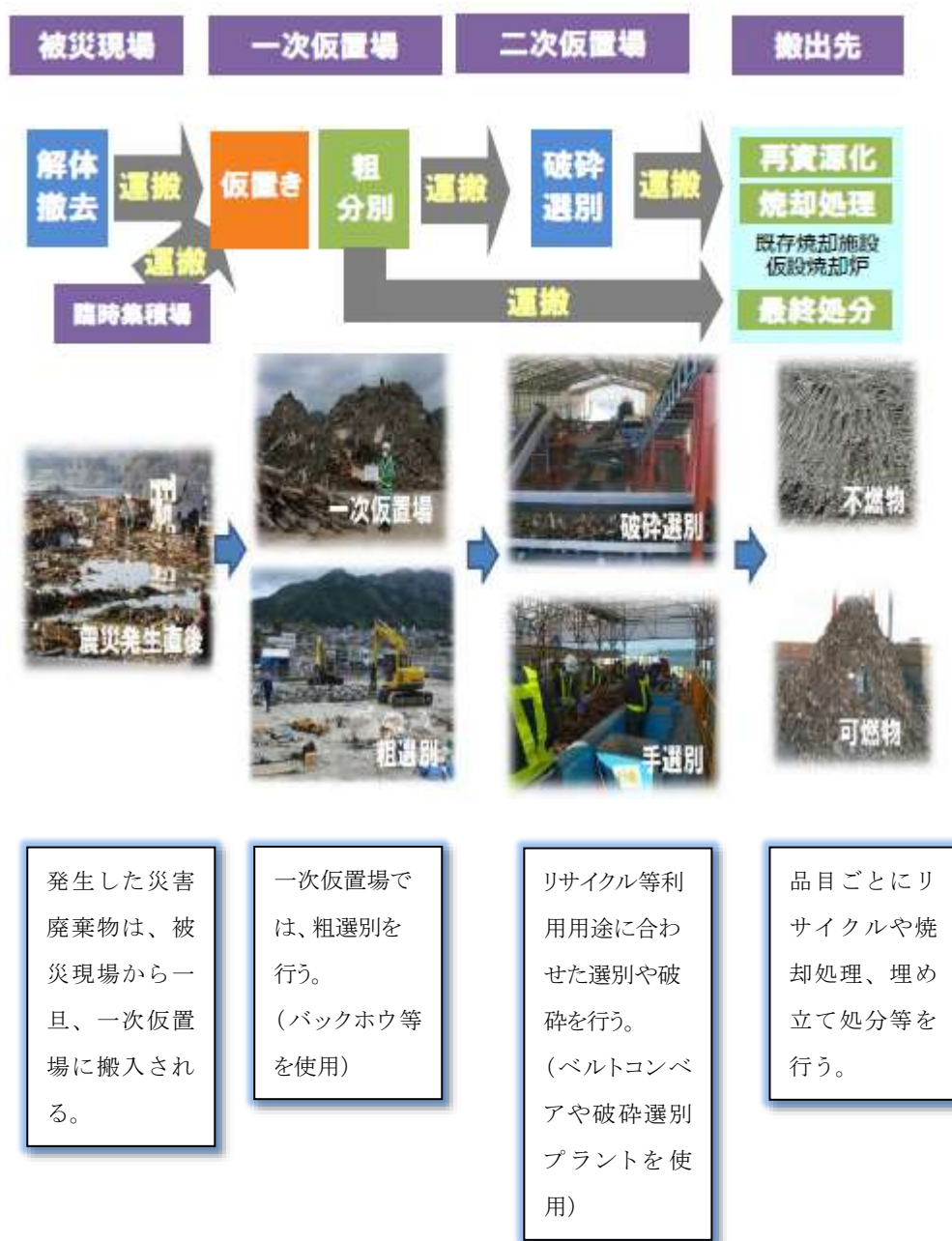
図2-3-3-6 仮置場への搬入、仮置場から搬出の流れ
