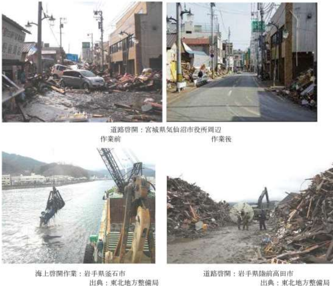
図 2.1 道路啓開状況
