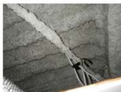
天井吹き付け材
