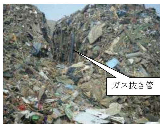
混合物の山に設置されたガス抜き管
