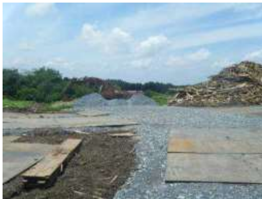
仮置場搬入路に敷設された砂利・鋼板 (宮城県松島町)
