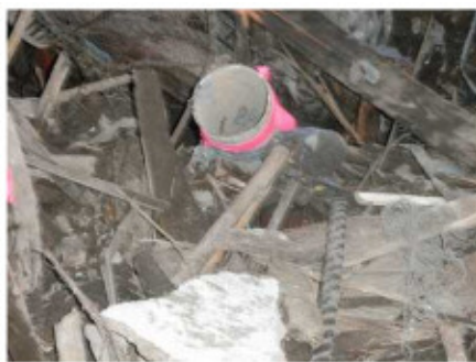
火災予防対策（ガス抜き管の設置） 岩手県宮古市宮古町松島園二次仮置場
