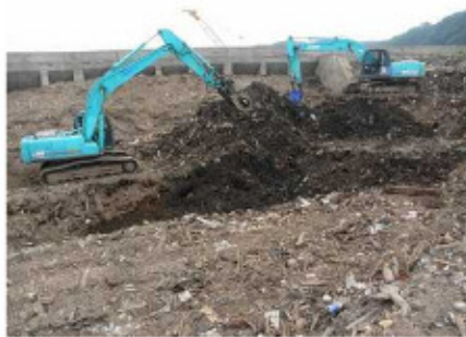
重機による災害廃棄物の山の掘削 岩手県宮古市田老一次仮置場
