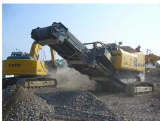
移動式コンクリート破碎機
