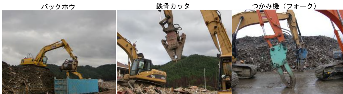
図 3.7 解体用建設機械の一例
