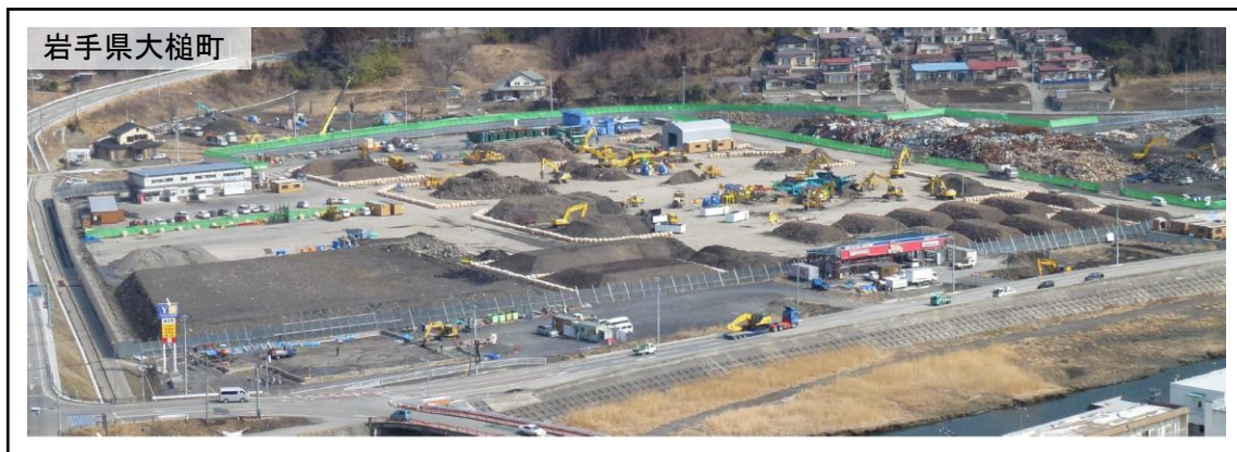
図 2-6-(6)-3 二次仮置場の例
