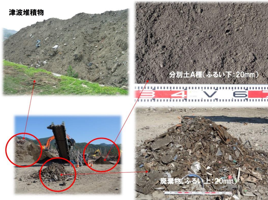
図 2-6-(8)-2 津波堆積物のふるい選別（乾式分級）の例
