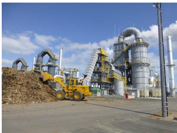
仮設焼却炉施設（福島県相馬市）
