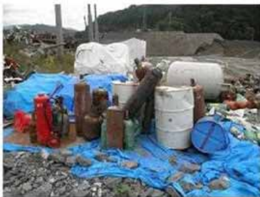
高圧ボンベ等の分別保管 (岩手県釜石市)
