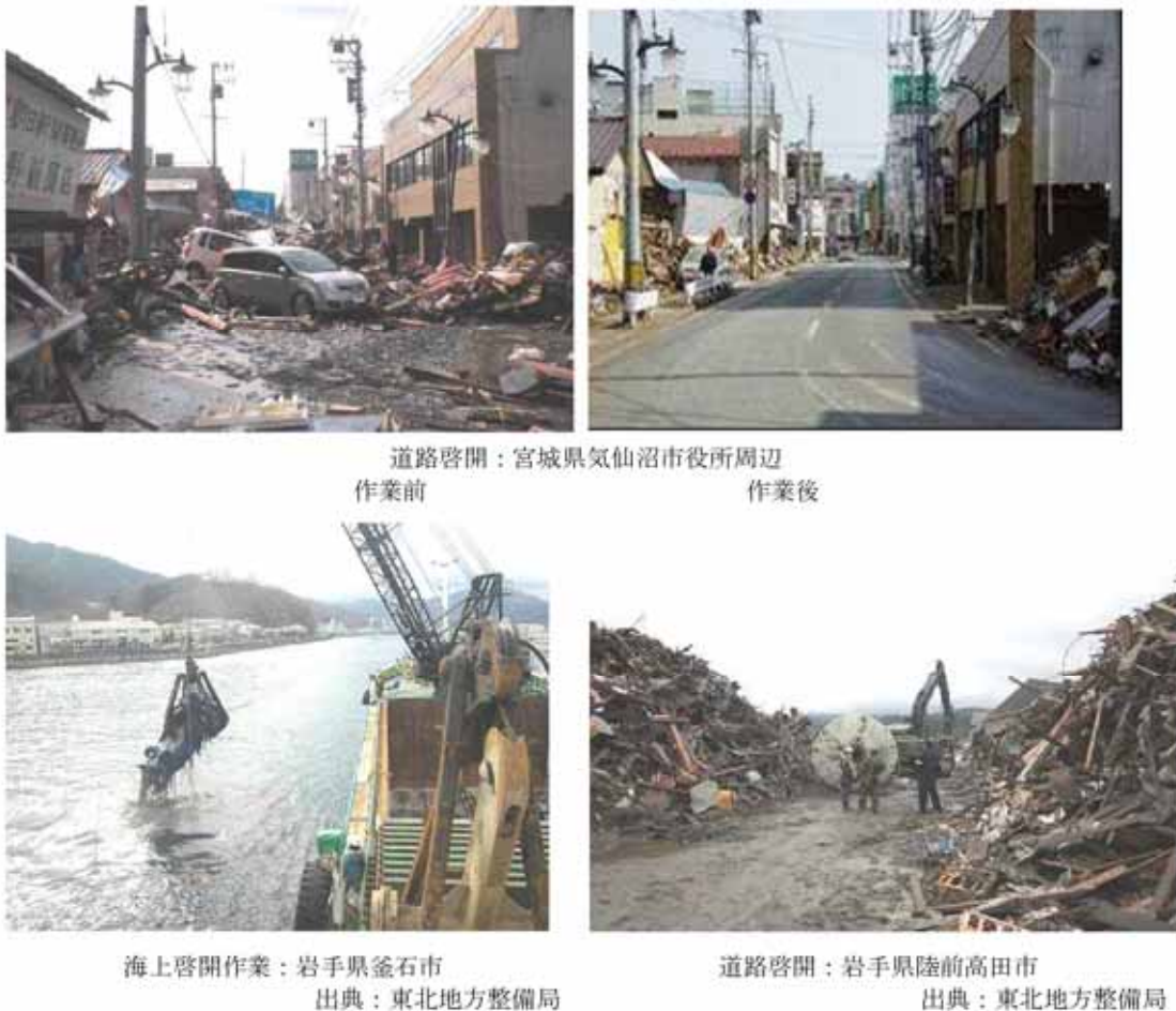
図 2.1 道路啓開状況
