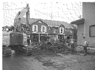
重機と手作業で分別・撤去を進める
