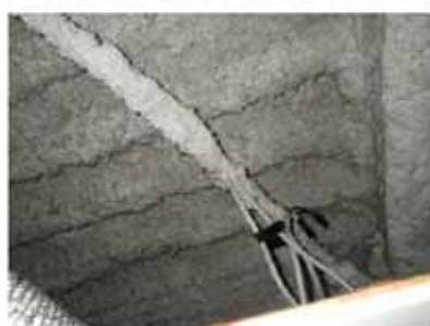
天井吹き付け材
