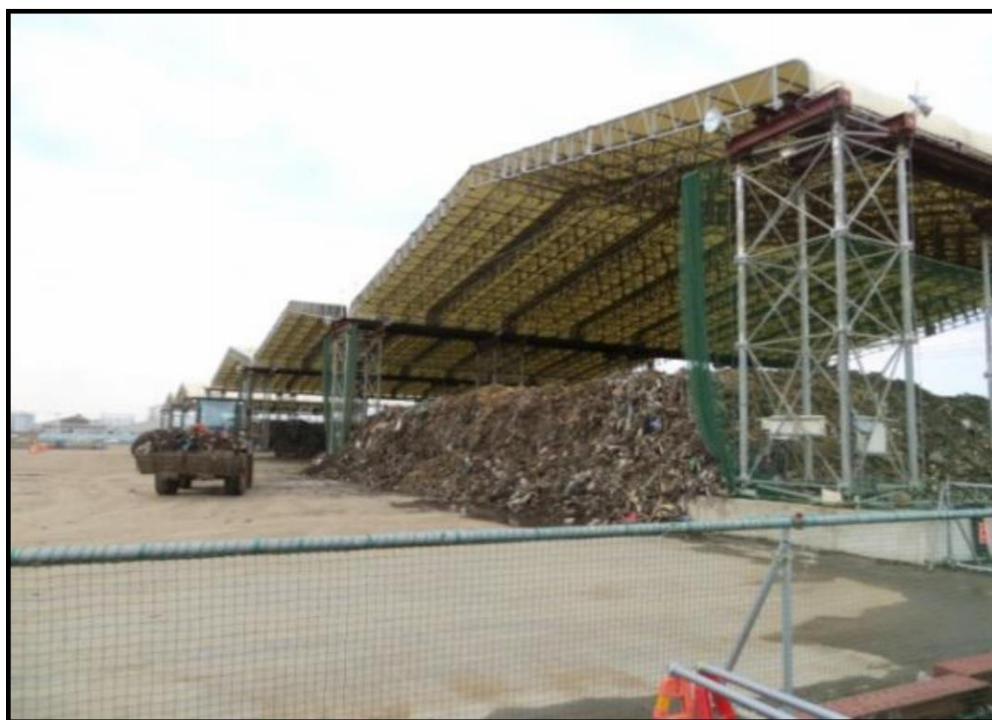
図 2.6-10 可燃物保管用の大型テント（雨や雪によるゴミ質の悪化対策）
