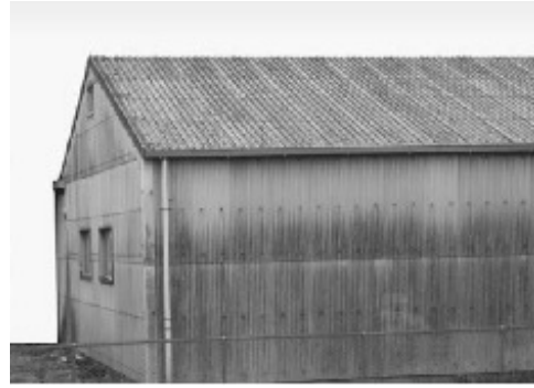
石綿含有スレート波板（屋根・外壁）
