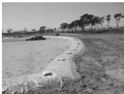
遮水シートを敷設した仮置場の事例 出典：仙台市 HP
