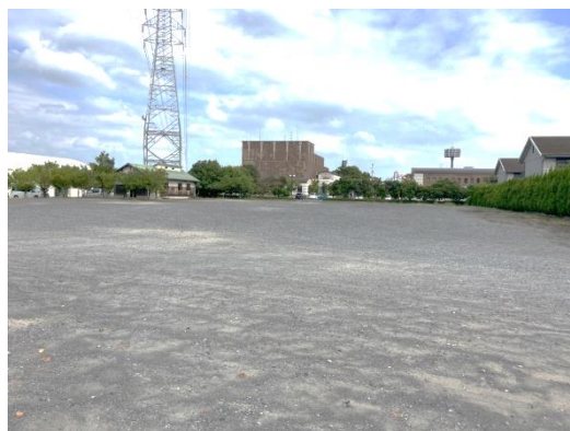
全景（南側より）
