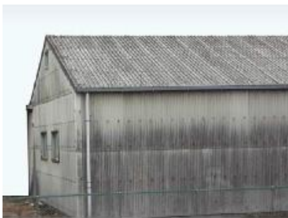
石綿含有スレート波板（屋根・外壁）
