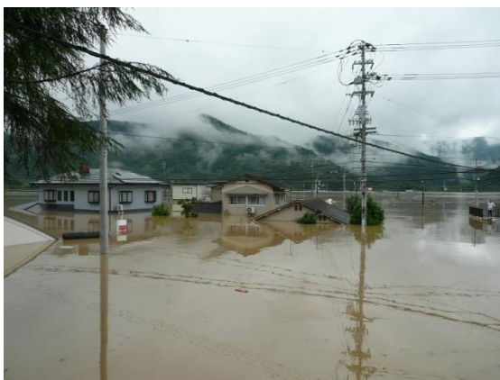
平成30年7月豪雨被害状況（大洲市）
