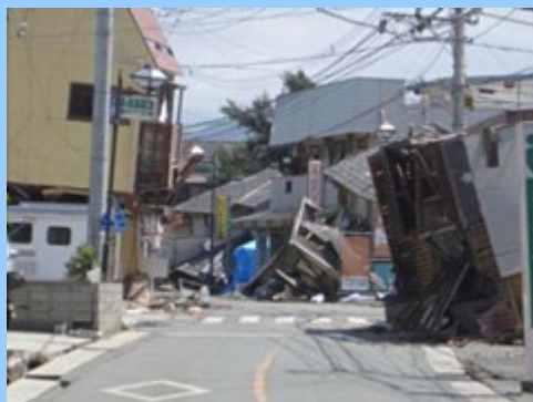
平成28年熊本地震の被害状況
