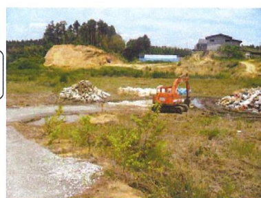
搬入路に碎石を敷き、水溜まり解消を図っている（松島町）
