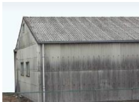
石綿含有スレート波板（屋根・外壁）
