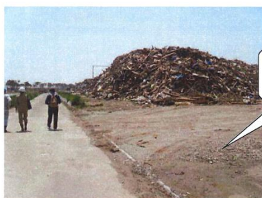
敷地内の一部に碎石を撒くことにより、水溜まりの解消を図っている（仙台市）
