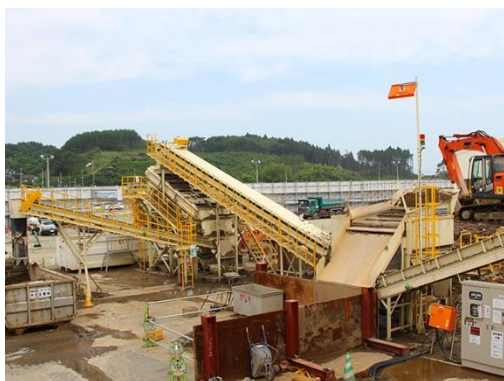
破碎選別施設の状況
